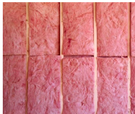
Insulation (wall, ceiling)
