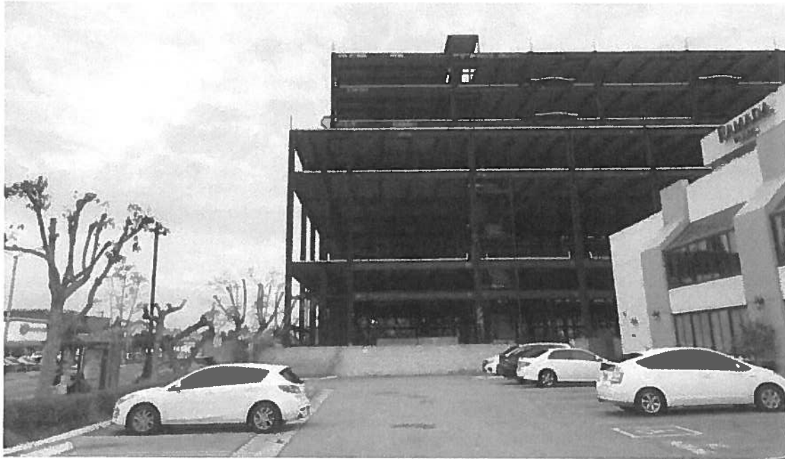
Kiến trúc cao năm tầng, với sườn sắt, xây dở dang từ năm 2009, trên đường Garden Grove Blvd, bên cạnh Ramada Plaza, đối diện Kia Garden Grove. (Hình: Công Thành/Người Việt)
